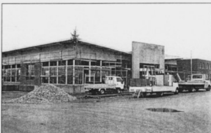
Kasberger baut neues Verkaufs- und Ausstellungsgebäude
